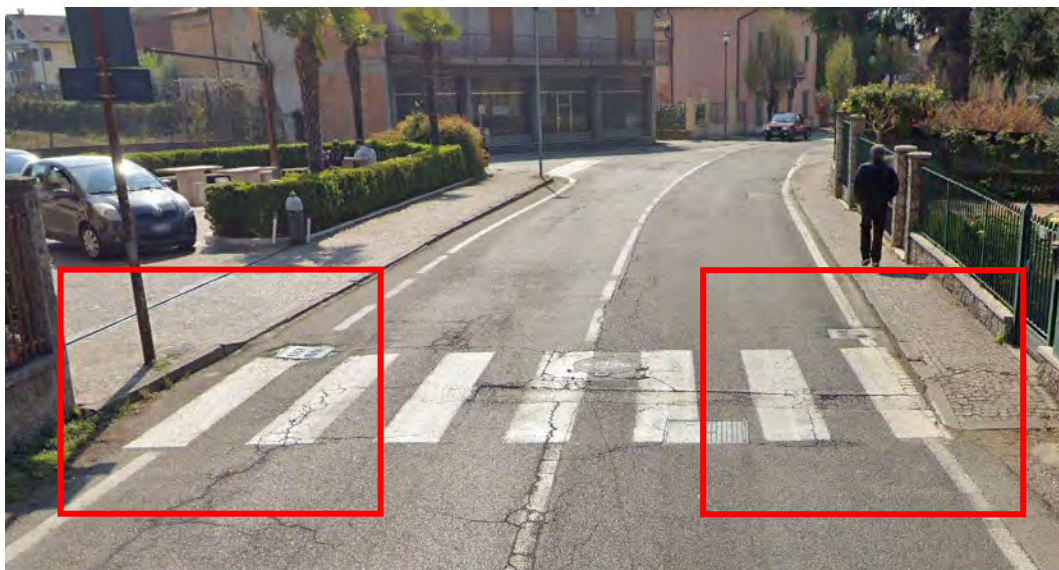
Intervento viale Verona – attraversamento pedonale su viale Verona fronte gelateria California privo di abbassamenti
