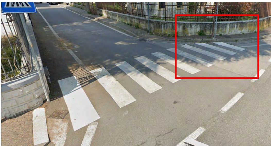
Figura 16 - Intervento via Prese – attraversamento pedonale all'incrocio con viale Verona privo di abbassamento e larghezza marciapiede insufficiente (<90cm)
