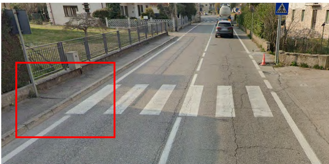
Figura 15 - Intervento via Pompea – attraversamento pedonale fronte chiesa privo di abbassamento
